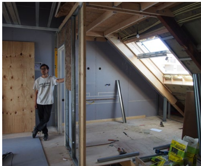
Een schoolgebouw aan de Duinstraat in Scheveningen wordt op initiatief van een groep eigenaar-bewoners getransformeerd tot woongebouw. Bij verkrijging van het pand wordt overdrachtsbelasting berekend. Verrekening van btw over de aanneemsom is niet mogelijk.
